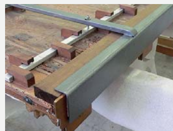
Particolare parchettatura e base di sostegno fine restauro.
