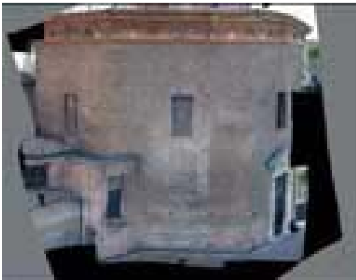
Restituzione del rilievo del Battistero effettuato a mezzo di laser scanner in collaborazione con il PIAC e la Soprintendenza Svedese
