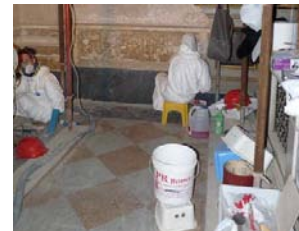
Il cantiere: il ritrovamento della "colla brodata" ed i restauratori durante i lavori di restauro all'interno della Chiesa
