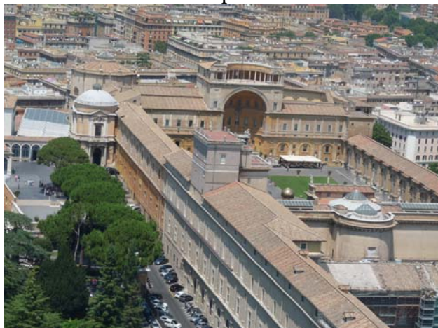
Vista dall'alto del viale dello Stradone ai Giardini.
